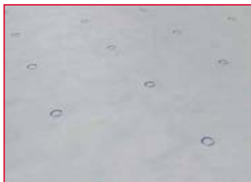
Dachbahn ausrollen, Säume verschweißen, Befestigungspunkte auf der Dachbahn markieren
