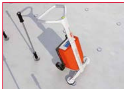
Befestigungspunkte durch Induktion mit der Dachbahn verschweißen
