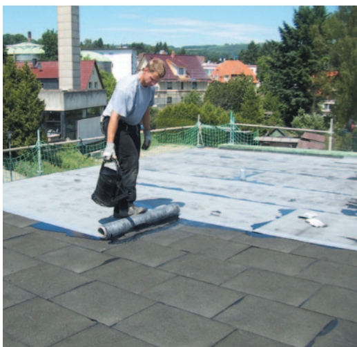
Verklebung mit Heißbitumen
