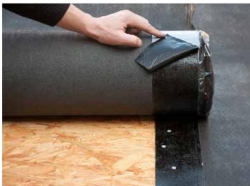
*Im Bereich der Längsnaht wird die Unterdeckbahn mit Breitkopfstiften verdeckt mechanisch fixiert*
