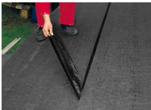
*Durch das Abziehen der Trenn-/Schutzfolien von den Längsnahtüberdeckungen werden diese selbstklebend verbunden.*
