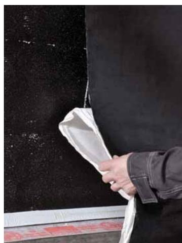
Von der Folie auf der Rückseite wird oben ein Streifen abgetrennt, die Bahn wird am oberen Rand fixiert. Dann wird der Rest der Folie nach unten abgezogen, die Bahn wird glatt gestrichen und aufgewalzt.
