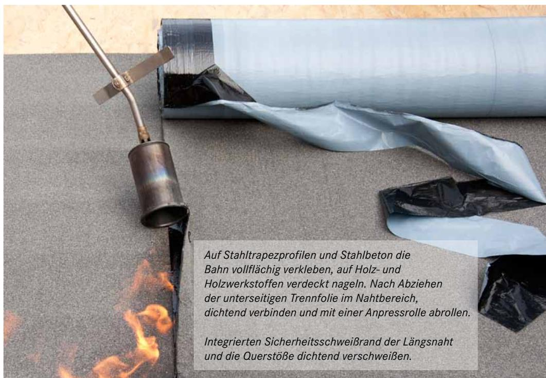
*Auf Stahltrapezprofilen und Stahlbeton die Bahn vollflächig verkleben, auf Holz- und Holzwerkstoffen verdeckt nageln. Nach Abziehen der unterseitigen Trennfolie im Nahtbereich, dichtend verbinden und mit einer Anpressrolle abrollen.*
