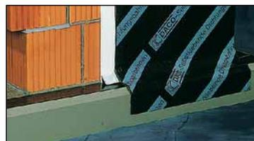
die Mauersperrbahn “herangeführt”, sondern mit den Überlappungsstreifen verschweißt bzw. kaltselbstklebend verbunden werden. Auf diese Weise kann in Kombination mit der vertikalen Außenwandabdich-
